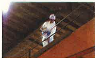
油圧プレス機の調査と センサ設置作業中の様子
