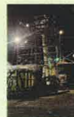
管路施工現場写真
