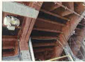
写真1 トンネルセントルに取り付けた発熱体
