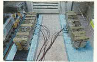
写真2 発熱体による給熱養生と温度計測
