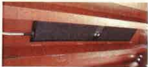
写真1 トンネルセントルに取り付けた発熱体
