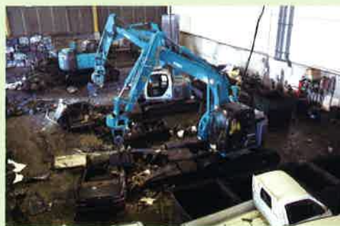
車両解体現場風景
