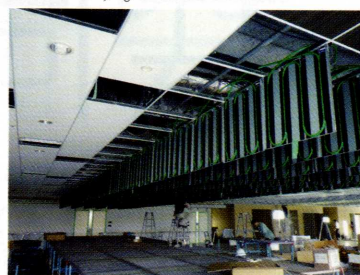
↑ 輻射式冷暖房システム、施工事例
