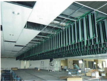
↑放射式冷暖房システム、施工事例
