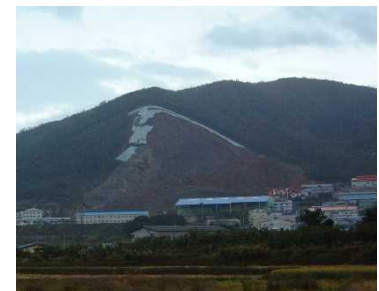
金海市で発生した地すべり(韓国)
