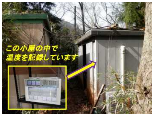
地すべり地での計測例
