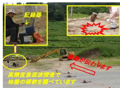
天然ダム堤体上での表面波探査例
